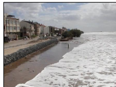
Partido de La Costa: defensa con gaviones.
